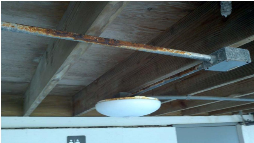
Rusting electrical conduit
